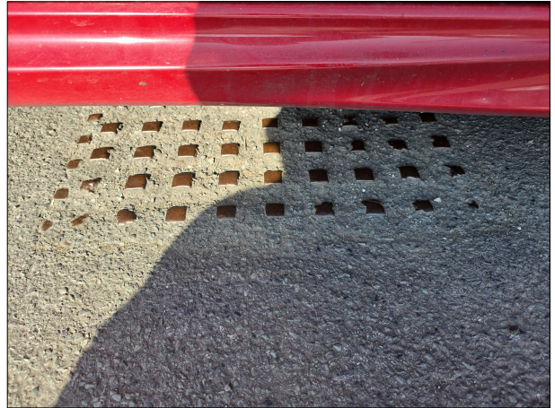
Photo: 20250401_112426.jpg 0m, General remark
