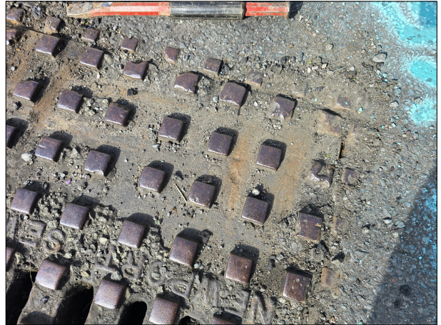
Photo: 20250401_114614.jpg 0m, General remark
