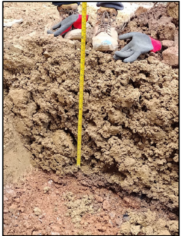
Plots 144-149 (before topsoil)
