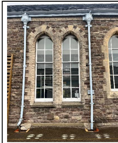
Sash windows SE Elevation
