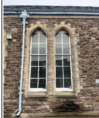
Sash windows SE Elevation
