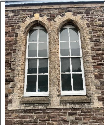
Sash windows SE Elevation
