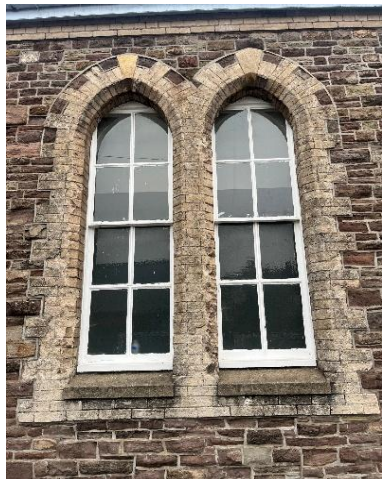
Sash windows SE Elevation
