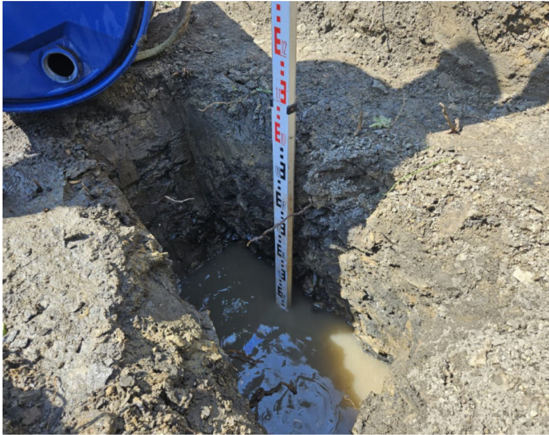
Test 1 - Max fill point 410mm fill.
